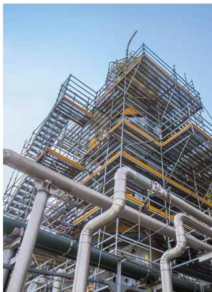
Les tours d'accès à volée simple présentent l'avantage d'offrir des plans de travail qui viennent s'ajouter aux volées d'escaliers.
