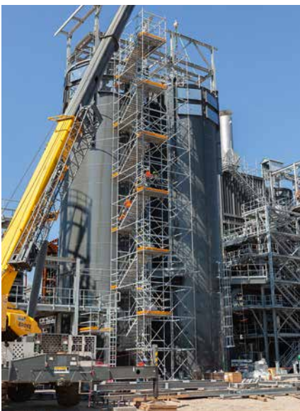
Les tours d'accès à double volée offrent une grande liberté de mouvement et une distance plus courte entre 2 niveaux.
