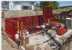
Coffrages de voiles
