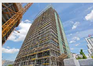
Echafaudages de façades
