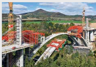
Coffrages de ponts
