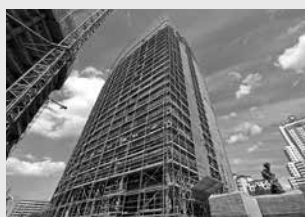
Echafaudages de façades
