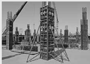
Coffrages de poteaux
