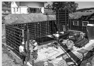
Coffrages de voiles
