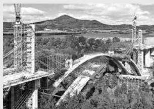
Coffrages de ponts
