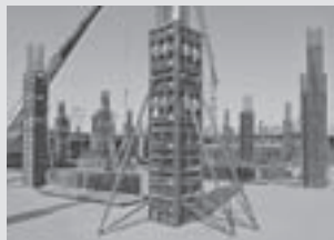
Coffrages de poteaux
