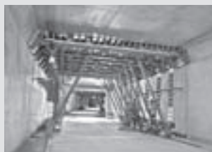
Coffrages de tunnels
