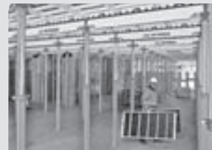
Coffrages de dalles
