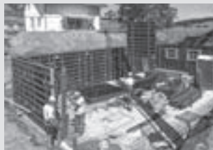
Coffrages de voiles
