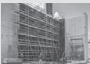
Echafaudages de ferrailage
