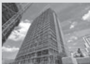
Echafaudages de façades
