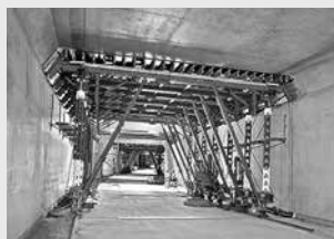
Coffrages de tunnels
