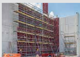
Echafaudages de ferrailage
