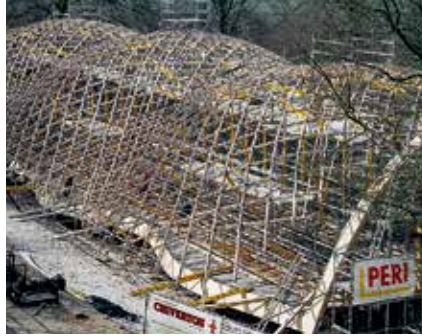
Les étais MULTIPROP soutenaient la structure en bois et donnaient une forme incurvée à la coque en treillis.
