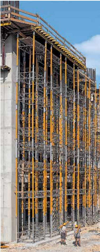
Tours MULTIPROP pour l'étalement d'une dalle en encorbellement de 20 m de haut.
