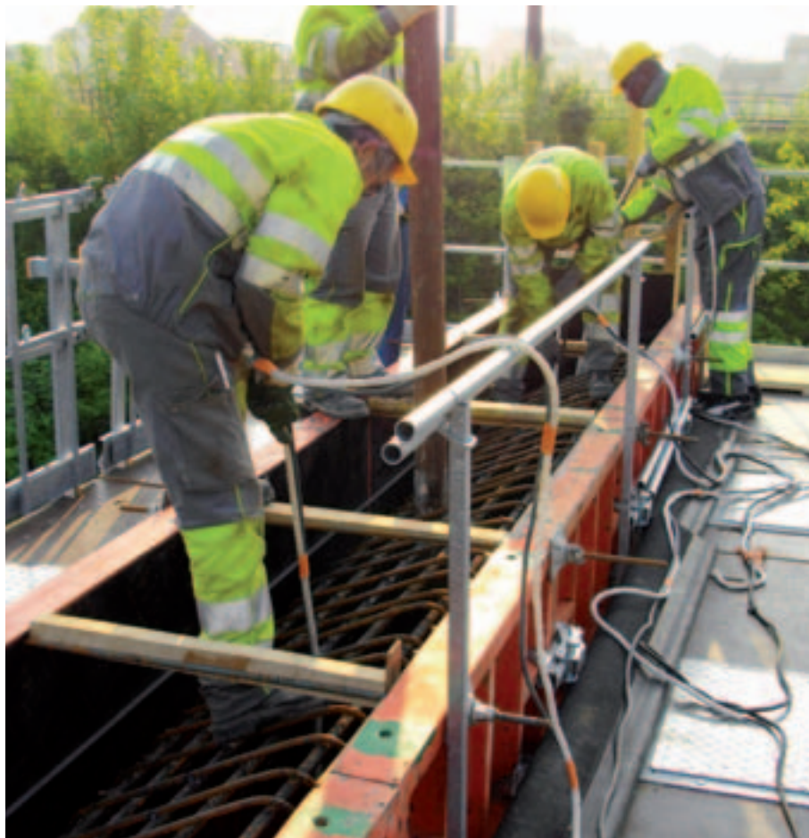
Travail sécurisé sur la plate-forme MXP.
