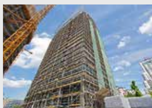
Echafaudages de façades
