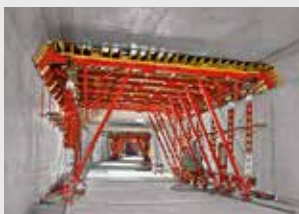
Coffrages de tunnels
