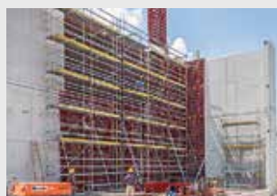
Echafaudages de ferrailage
