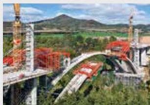
Coffrages de ponts
