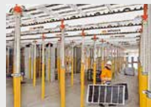
Coffrages de dalles
