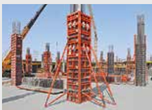
Coffrages de poteaux
