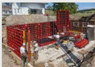
Coffrages de voiles
