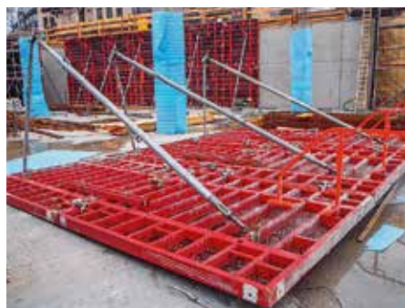
Montage simple et sûr d'étais de réglage et contre-flèches sur le coffrage disposé à plat ...
