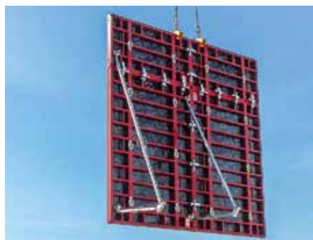
... déplacement à la grue des systèmes de coffrages prémontés pour voiles, étais de réglage inclus ...
