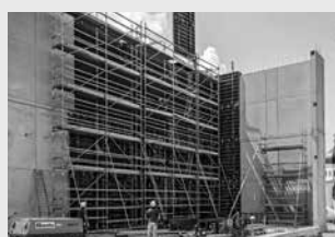
Echafaudages de ferrailage
