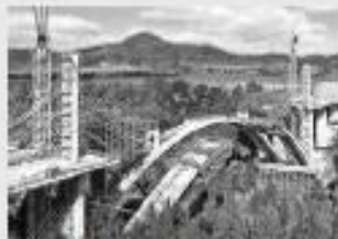
Coffrages de ponts
