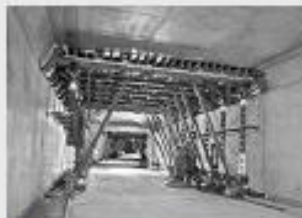
Coffrages de tunnels
