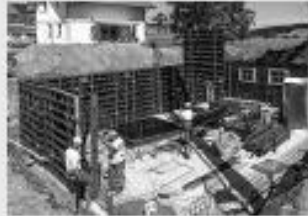
Coffrages de voiles
