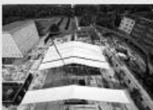
Echafaudages de protection
