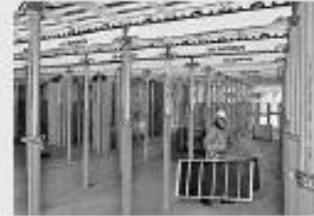
Coffrages de dalles
