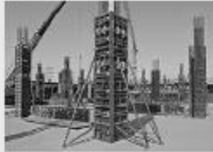
Coffrages de poteaux
