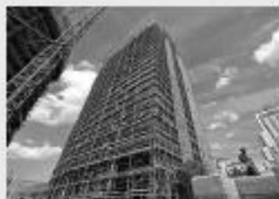
Consoles de travail façade
