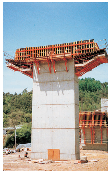
Ferme de butonnage PERI SB-2 servant d'appui pour le coffrage de chevêtres.
