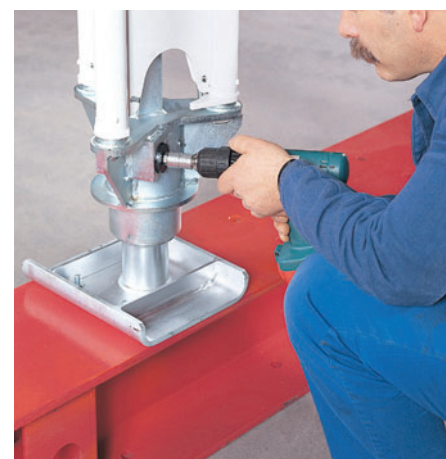
Une perceuse visseuse courante à ouv. 19 pour la manipulation (sans visseuse à percussion).
