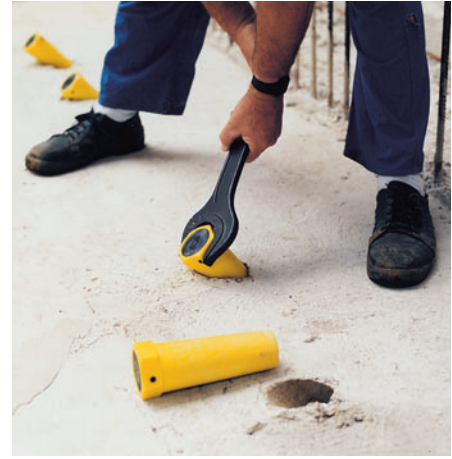
... et le démontage du cône d'implantation s'effectue aisément après le bétonnage.
