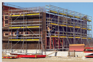
Echafaudages de ferrailage
