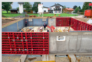
Coffrages de voiles
