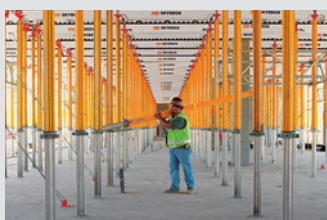
Coffrages de dalles
