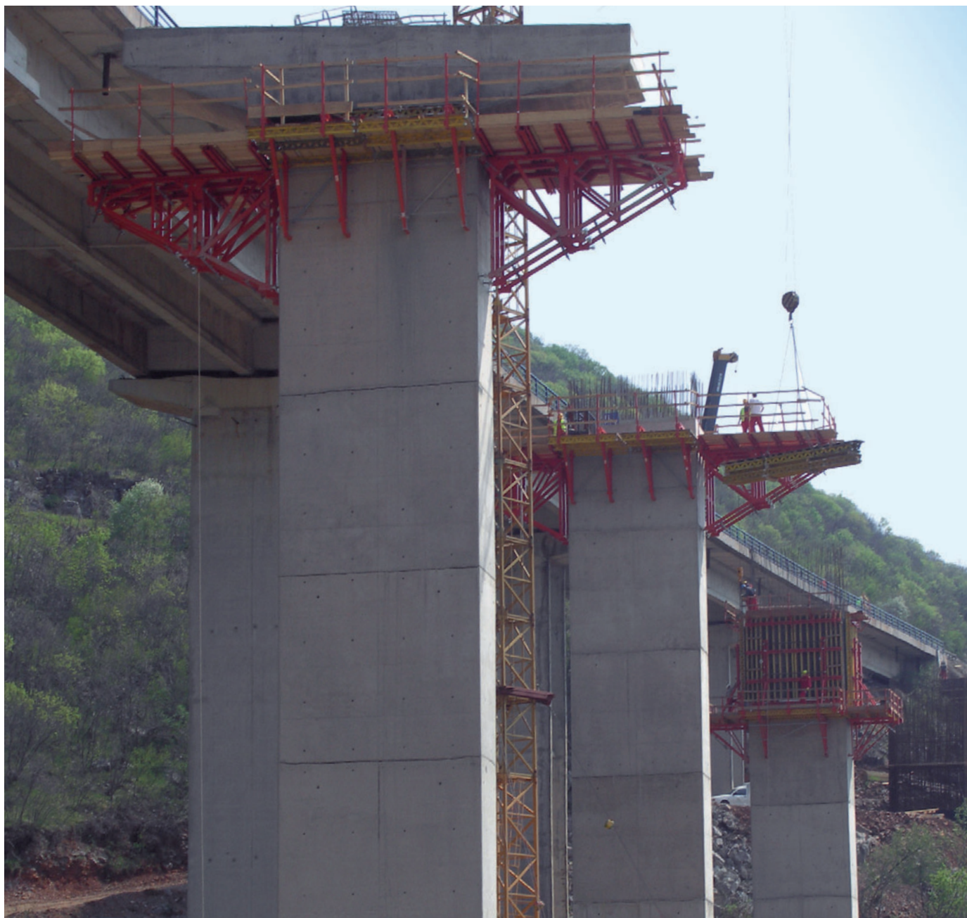
Utilisation du système de fermes de butonnage SB-A, B comme console de travail et console pour lourdes charges.
