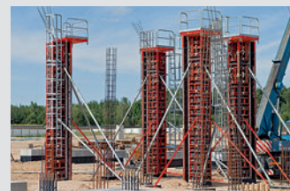
Coffrages de poteaux
