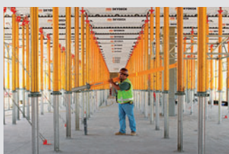
Coffrages de dalles
