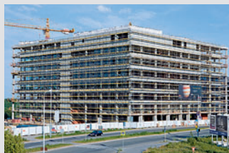
Echafaudages de façades
