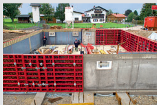
Coffrages de voiles
