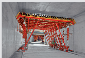
Coffrages de tunnels
