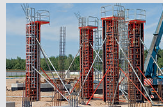
Coffrages de poteaux
