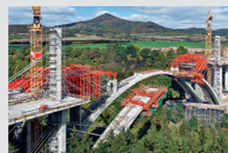
Coffrages de ponts
