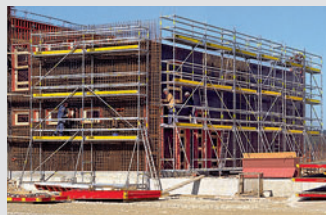
Echafaudages de ferrailage
