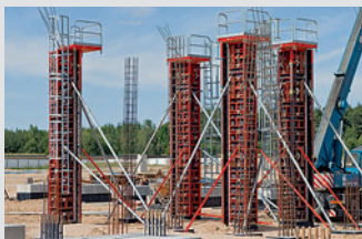
Coffrages de poteaux
