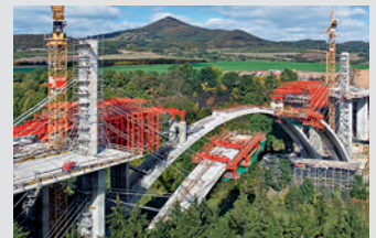
Coffrages de ponts
