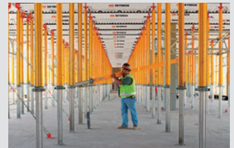
Coffrages de dalles
