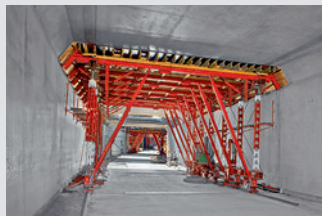
Coffrages de tunnels
