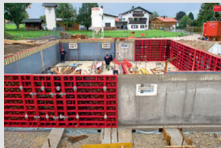
Coffrages de voiles
