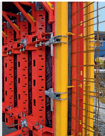
Les arrêts de coffrage incombant au chantier sont fixés sur le profil de rive des éléments RUNDFLEX Plus à l'aide de filières et d'ancrage d'about.
