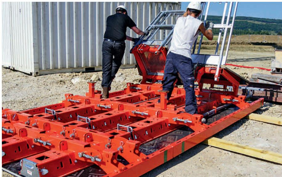
Avec la plate-forme adaptée, les garde-corps et l'échelle, les phases de mise en œuvre et de bétonnage se font en toute sécurité.
