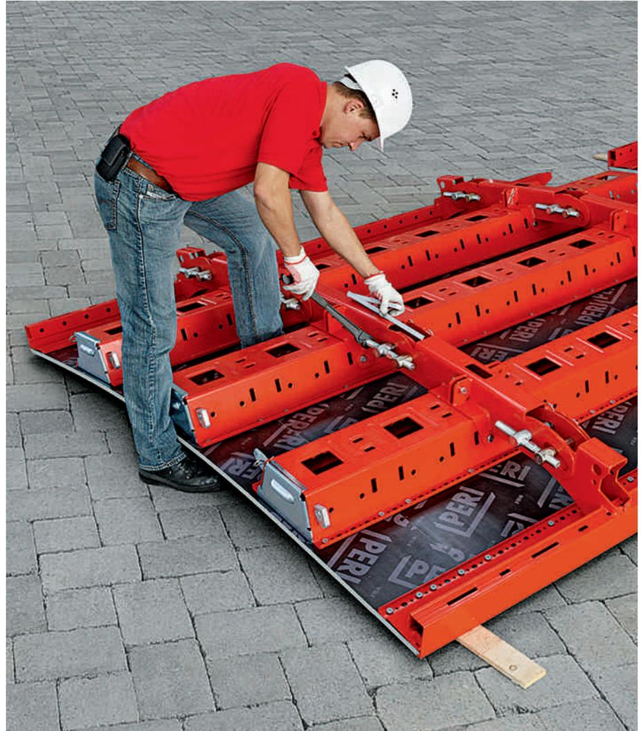
Régler : Grâce à la très judicieuse conception du système RUNDFLEX Plus, peu de vérins doivent être manœuvrés. Le réglage ou la modification des rayons peut également être effectué sur des éléments entièrement équipés de plate-formes.
