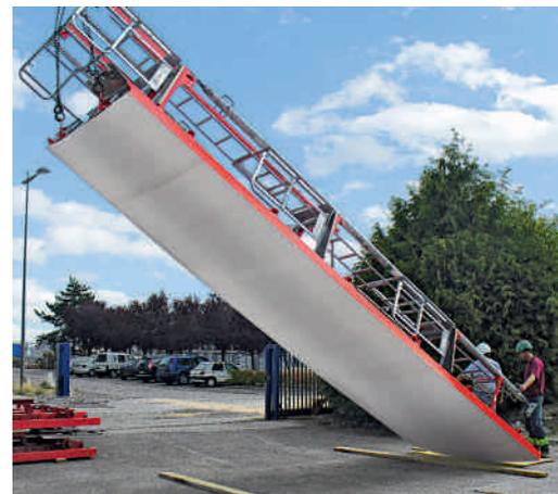
La superposition rigide, sans risque de glissement, permet le levage de grandes unités de coffrage.
