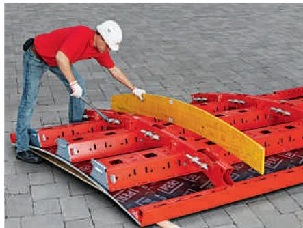
Régler précis : A l'aide d'un gabarit, les éléments sont ajustés exactement au rayon.
