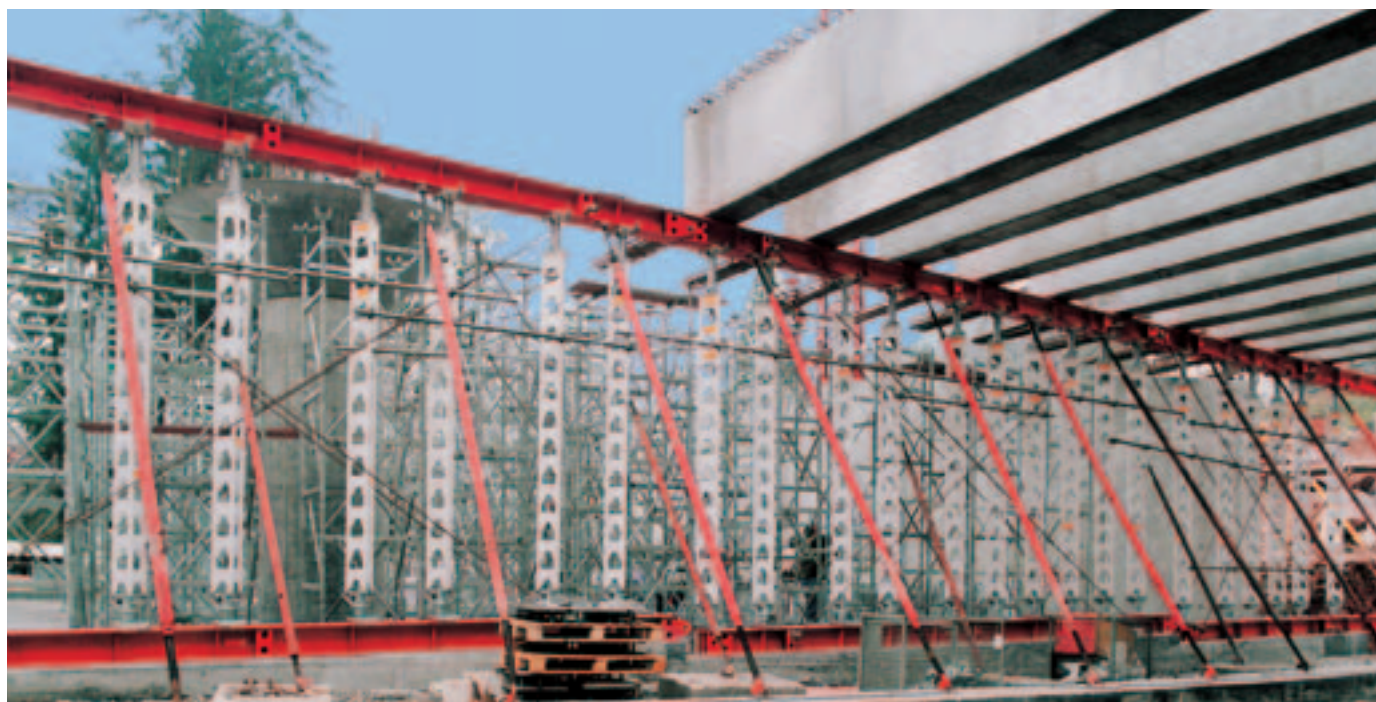
La console 75 HD pour un échafaudage de 75 cm de large. Distance maxi 1,25 m. Charge adm. 150 kg/m 2 .
